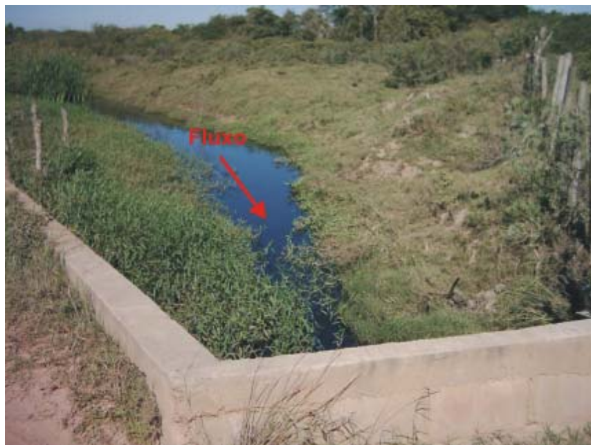
Foto 62: Ponto de lançamento do efluente da ETE de Cabo Frio.
