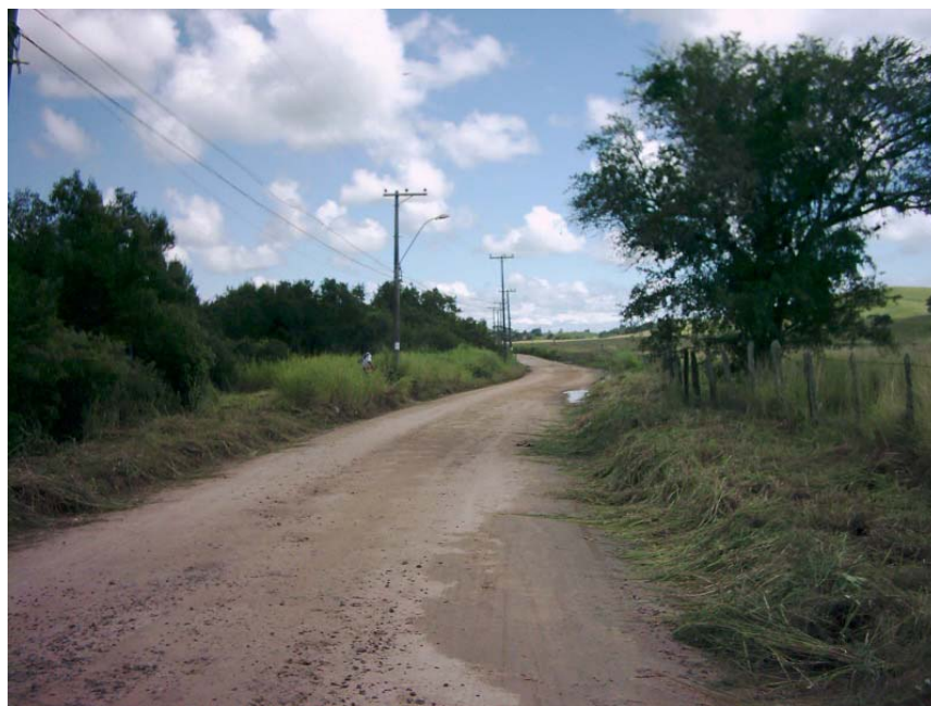
Foto 35: Estrada para a passagem da tubulação ao lado da ETE de São Pedro da Aldeia.
