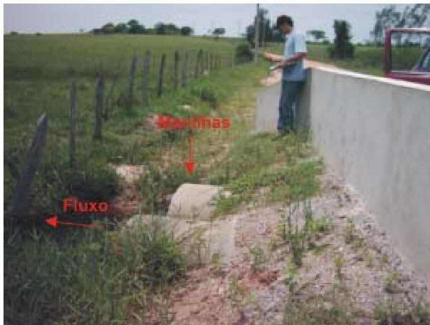
Foto 29: Detalhe das manilhas da travessia do córrego Arrozal sob a ponte.
