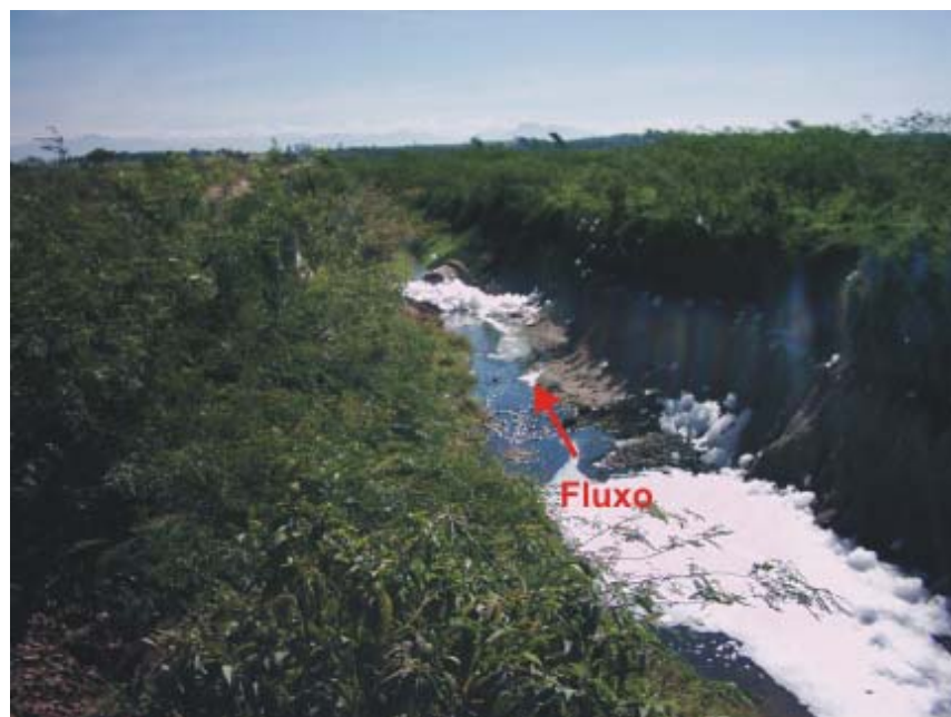
Foto 63: Vala aberta pela prefeitura podendo-se notar o acúmulo de espuma. Essa vala já recebe os esgotos dos bairros periféricos de Cabo Frio.
