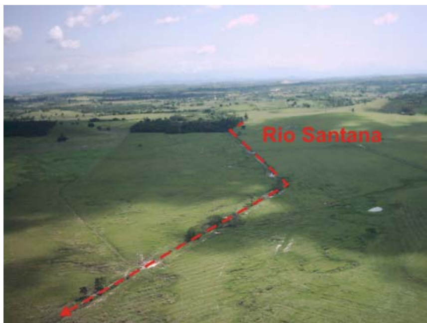
Foto14: Continuação da calha do Rio Santana a jusante.
