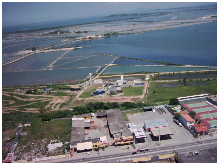
Foto 4: Estação de Tratamento de Esgoto de Cabo Frio
