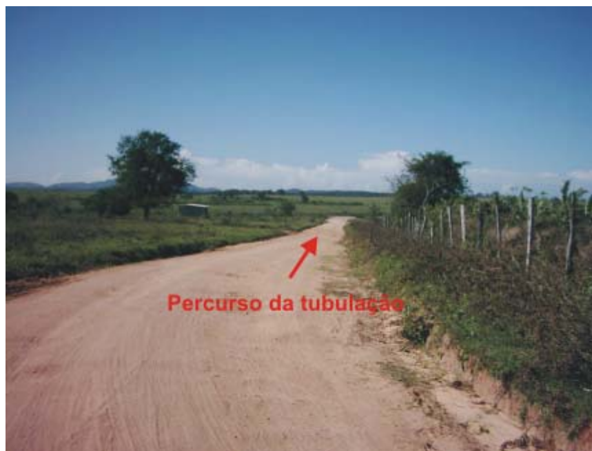
Foto 61: Último trecho percorrido. Observa-se ao fundo o ponto de lançamento do efluente.
