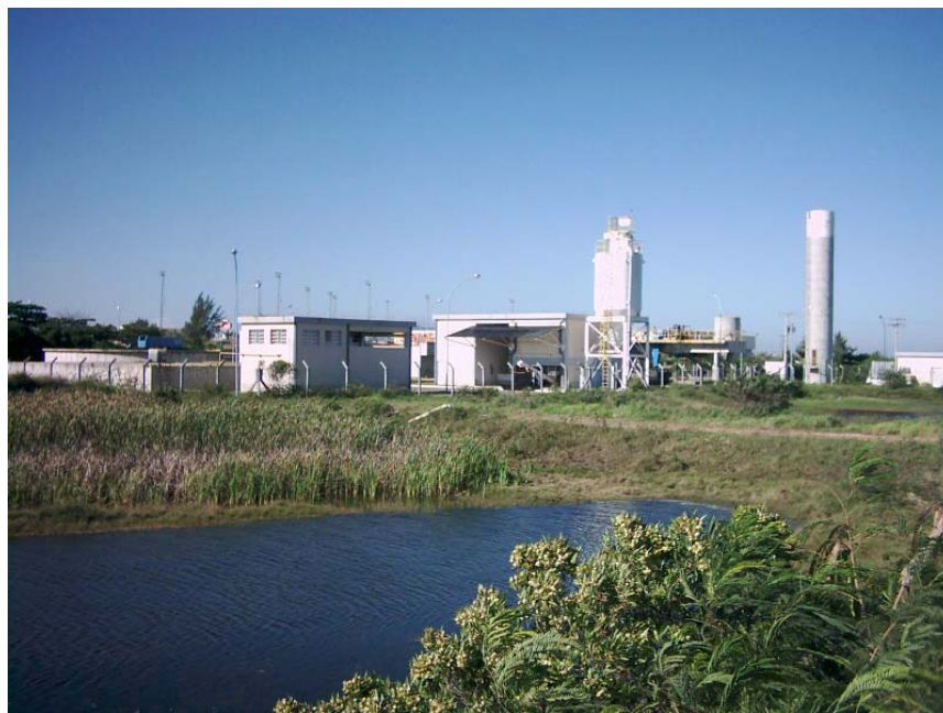
Foto 47: Estação de tratamento de esgoto de Cabo Frio.
