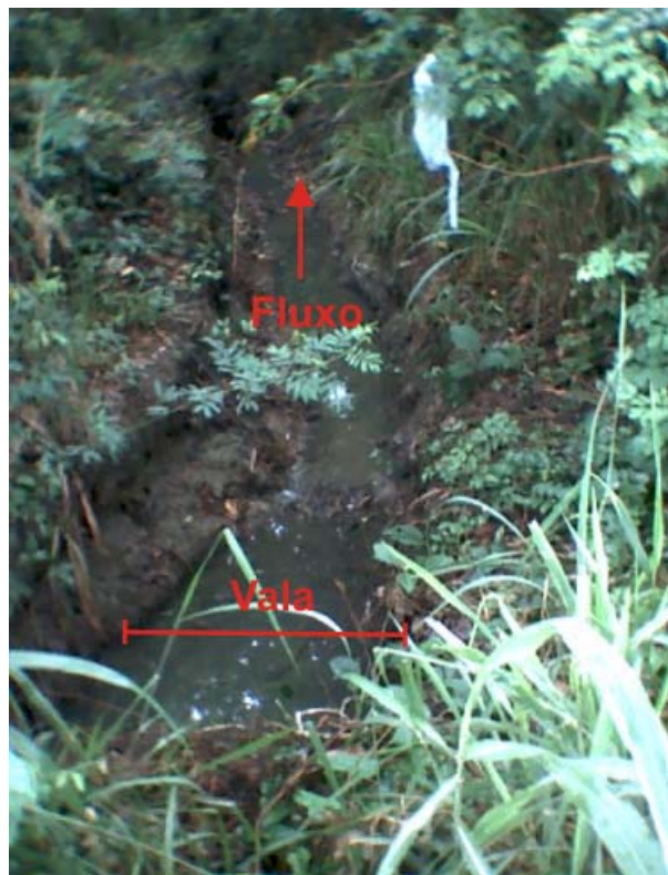
Foto 7: Detalhe da calha da vala.
