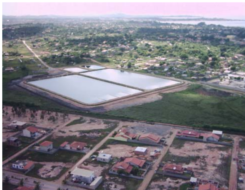
Foto 1: Estação de Tratamento de Esgoto de Araruama.
