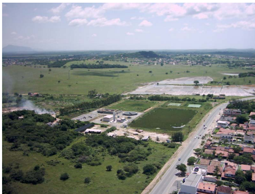
Foto 3: Estação de Tratamento de Esgoto de São Pedro da Aldeia
