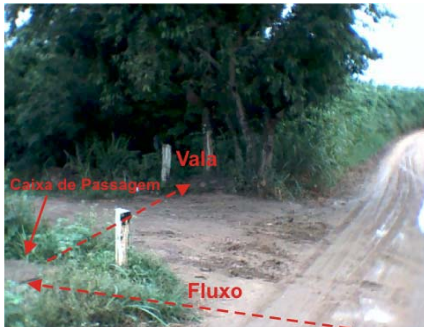
Foto 6: Ponto inspecionado como alternativa para receber os efluentes.
