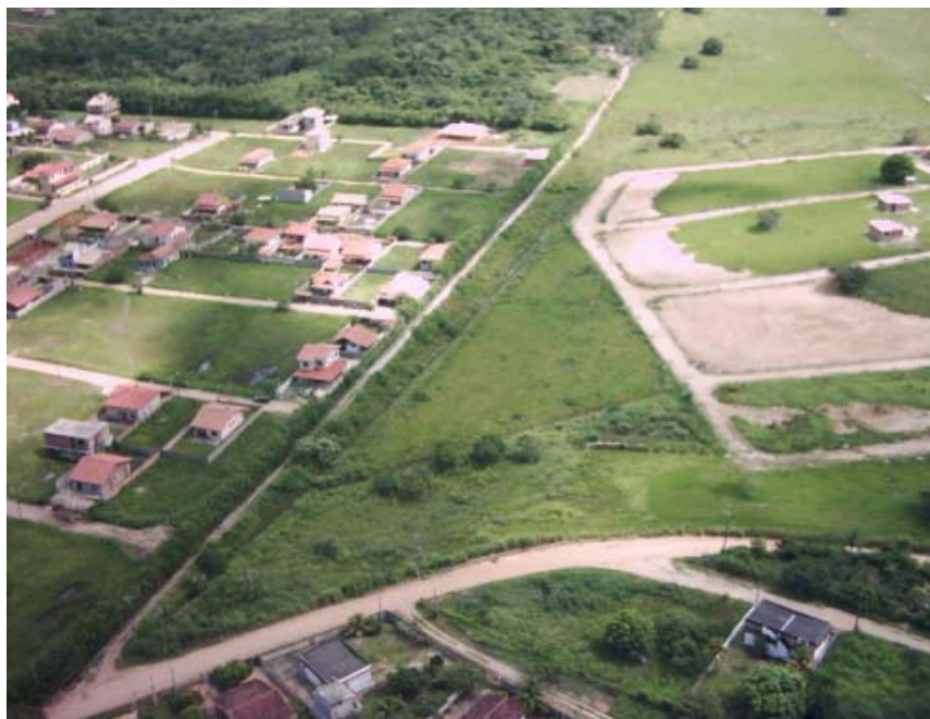
Foto 10: Vista da vala a montante, após o ponto de lançamento.
