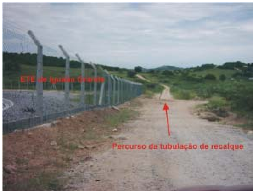
Foto 21: Início do trecho sugerido para implantação da tubulação ao lado da estação de tratamento.
