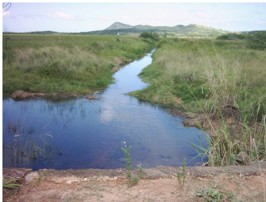
Foto 70: Canal artificial de drenagem da área brejosa onde se situa a atual lagoa de descarte
