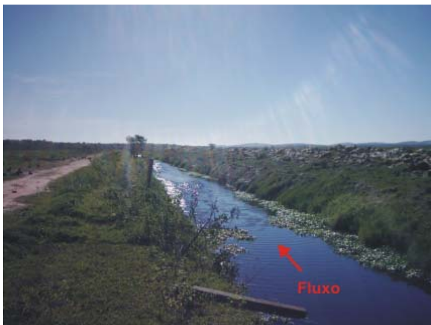
Foto 65: Continuação do canal de deságüe.
