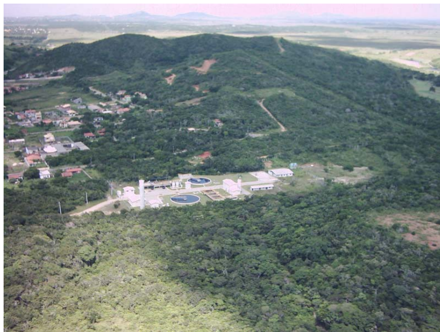
Foto 5: Estação de Tratamento de Esgoto de Armação dos Búzios
