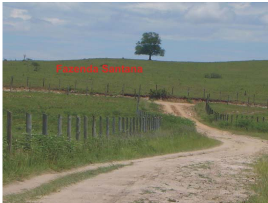
Foto 23: A tubulação cruza uma estrada de terra e continua pela Fazenda Santana.
