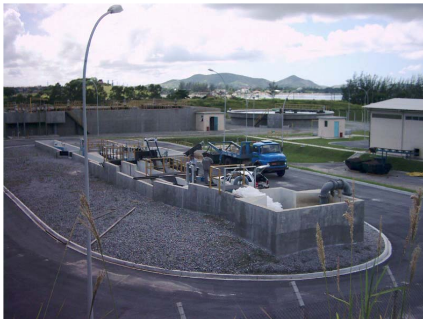
Foto 34: Estação de Tratamento de Esgoto de São Pedro da Aldeia.
