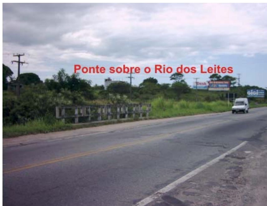
Foto 19: Ponte sobre o Rio dos Leites
